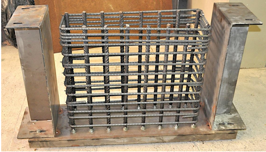
Figura 73. Montaje del encofrado paso 1.
