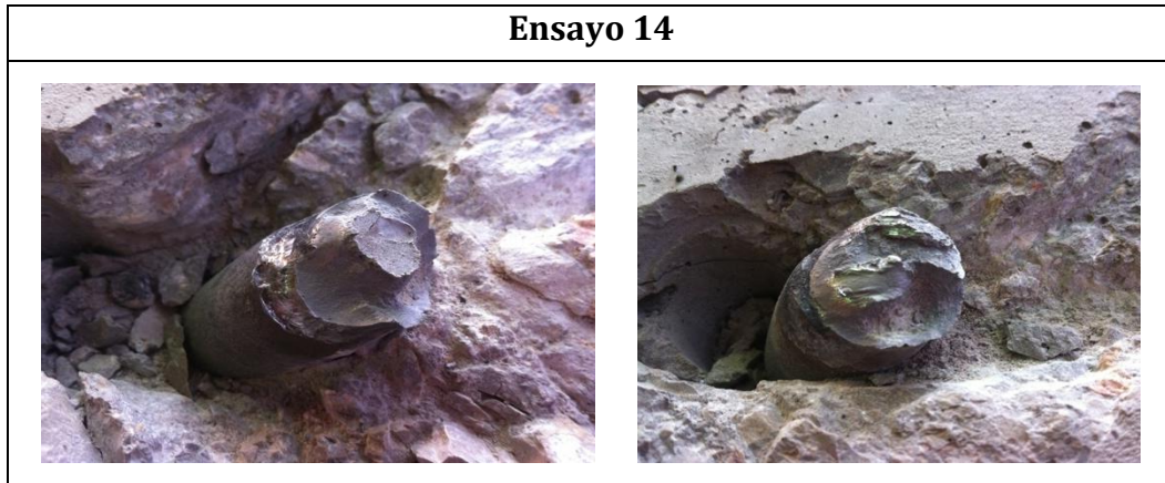
Figura 102. Rotura de la soldadura en el ensayo 14 de la disposición PPSEG.
