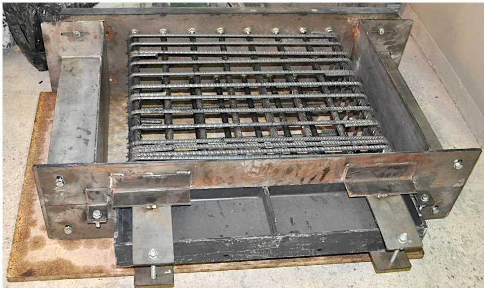
Figura 76. Montaje del encofrado paso 4.
