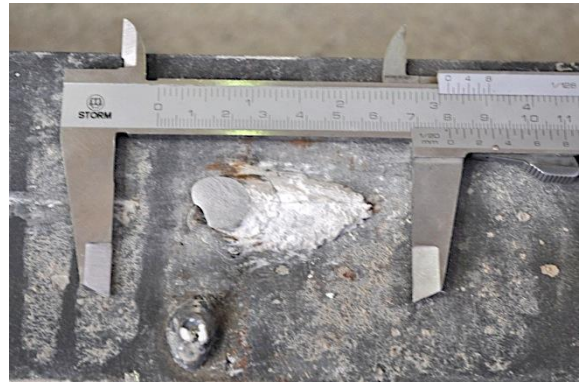
f) Detalle perno derecho tras rotura
