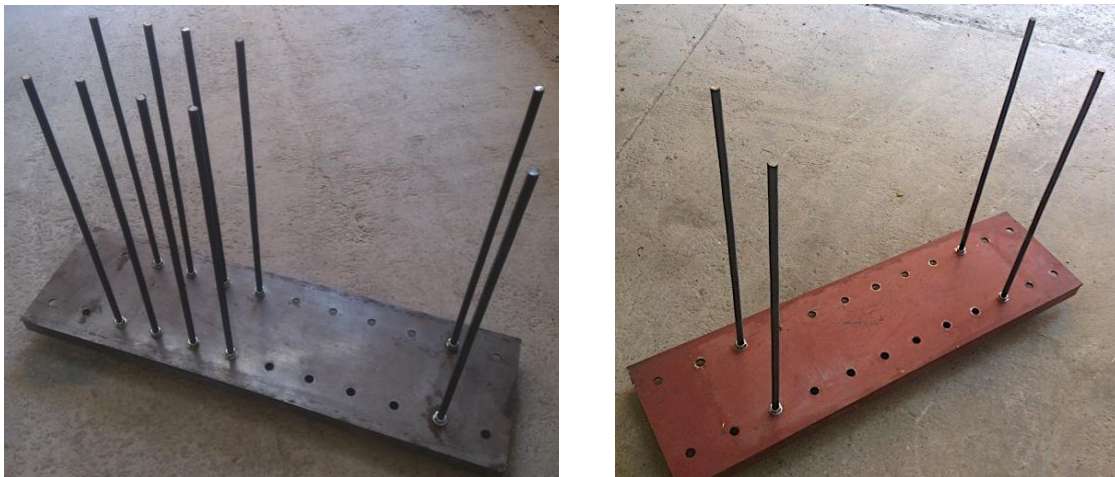
Figura 63. Ejemplos de armados longitudinales montados sobre la parte inferior del encofrado.
