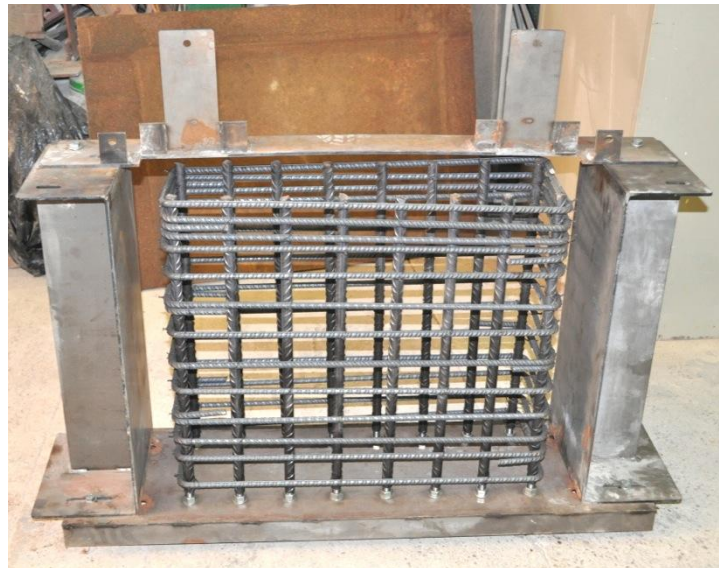
Figura 74. Montaje del encofrado paso 2.
