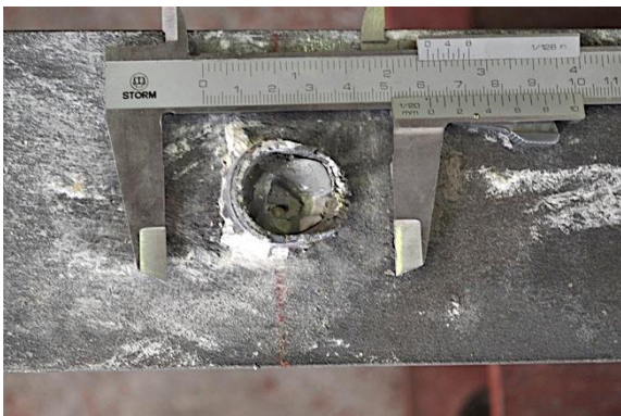
e) Detalle perno tras rotura
