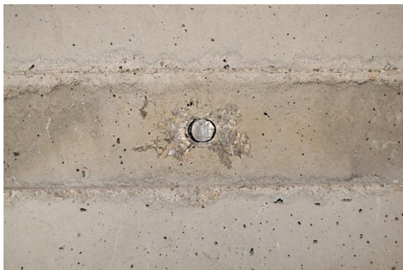
g) Detalle perno tras rotura
