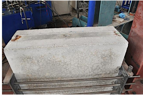
b) Detalle en rotura
