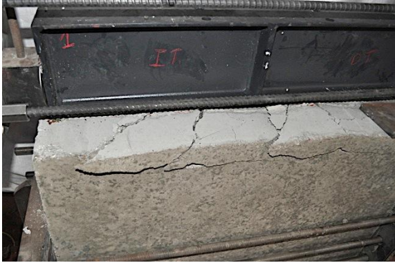
a) Detalle en rotura
