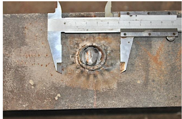
f) Detalle perno derecho tras rotura
