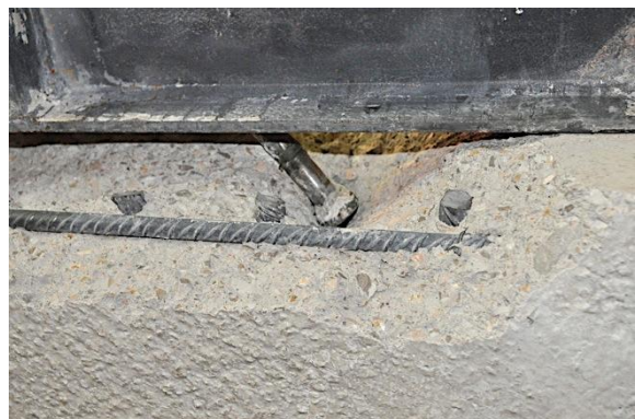
h) Detalle perno derecho tras rotura
