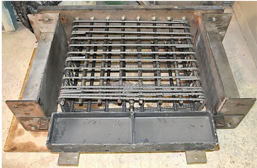
Figura 75. Montaje del encofrado paso 3.
