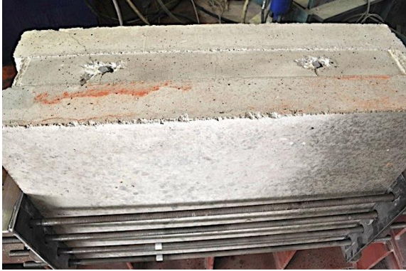
a) Detalle en rotura
